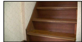
階段手すりあり昇降は介助します
